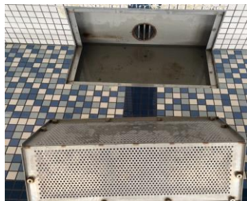
プール吸込口
